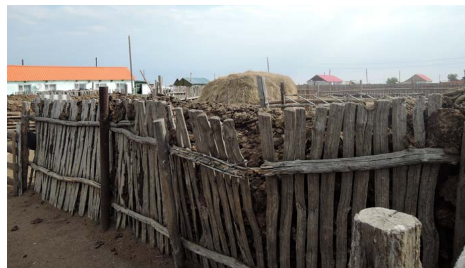
10. fénykép: A szárított árvaganéval töltött kétfalú szárnyék Photo 10. Double wall shelter filled with dried dung
